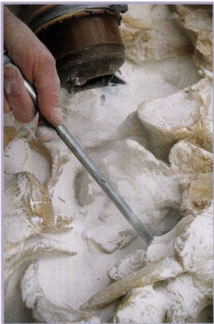
FIGUUR 2 Dankzij een verlengstuk zijn ook lastig bereikbare hoekjes te stralen.
