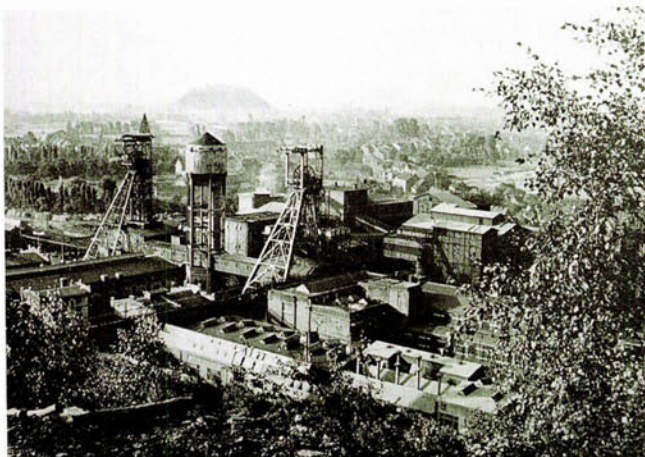
FIGUUR 1 Overzicht staatsmijn Wilhelmina, gefotografeerd vanaf de steenberg die naast de mijn lag. Links is de schachtbok van de 537 m diepe schacht II zichtbaar, rechts daarvan de watertoren en daarnaast de schachtbok van schacht I die een diepte van 821 m had. Uit: Staatsmijn Wilhelmina (M. KNEEPKENS, 1952).
