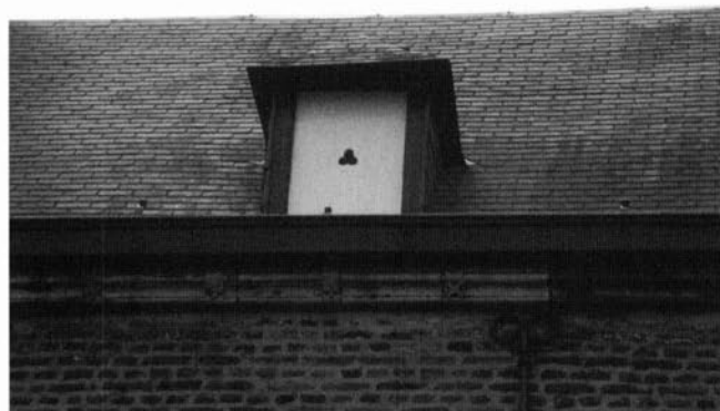
FOTO 7 Openingen in zijkapellen van kerkzolders fungeren als in- en uitvliegopeningen voor vleermuizen. Door de grootte aan te passen zijn deze ontoegankelijk voor duiven. Bovendien worden donkere kerkzolders gemeden door duiven (foto IKL).
