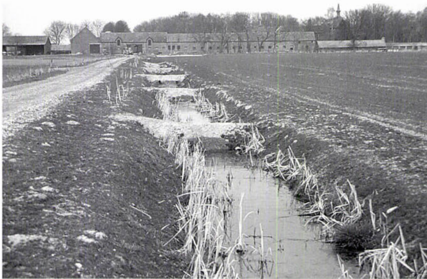
FIGUUR 7. Pas aangelegd helofytenfilter.
