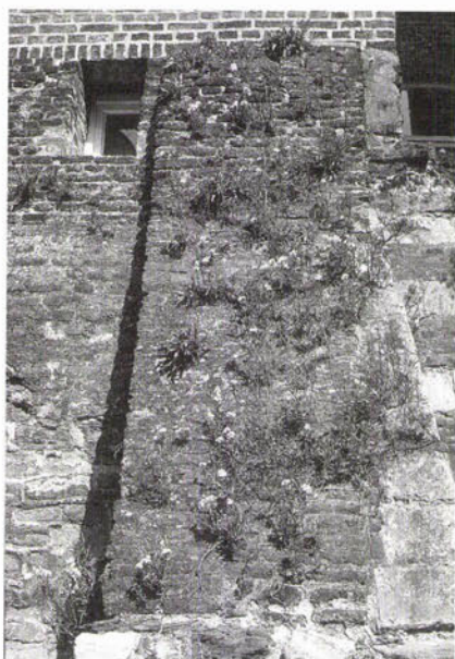
FIGUUR 9a. Steunbeer vóór de consolidatie. Duidelijk is te zien dat de Muurbloem alleen groeit op de schuine zijde van de steunberen of, zoals links onder, op plaatsen waar stenen ontbreken (foto: B. Graatsma).
