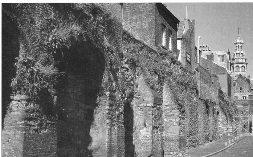
FIGUUR 2. De walmuur aan de Preekherengang in 1995, vóór de consolidatiewerkzaamheden. Links bevinden zich de muurbogen en in het midden en rechts de steunberen. Vooral de hogere delen van de muur en de steunberen zijn rijkelijk begroeid (foto: B. Graatsma).
