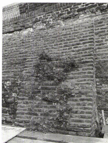
FIGUUR 10b. Steunbeer ná de consolidatie. Behalve de bovenzijde waren ook de randen van deze steunbeer door de tand des tijds aangetast. Alleen in het middendeel kon de Muurbloem behouden worden (foto: B. Kruyntjens).
