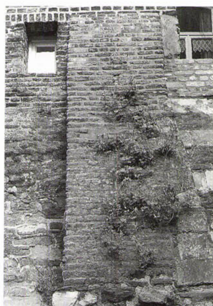
FIGUUR 9b. Steunbeer ná de consolidatie. Omdat het metselwerk aan de bovenzijde van de steunbeer erg los zat, zijn hier de meeste planten verwijderd (foto: B. Kruyntjens).
