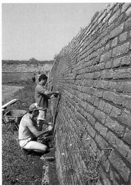
FIGUUR 5. Met satéstokjes is aangegeven welke holletjes bij het voegen open gelaten moesten worden (foto: B. Kruytenjens).
