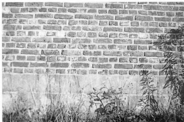
FIGUUR 1. Slecht voorbeeld van restauratie uit 1977: alle holletjes, richeltjes, uitstekende stenen en muurvegetaties zijn weggerestaureerd met keiharde Portlandcement. In de mergelplint zijn nergens meer holletjes of zonneplateautjes aanwezig (foto: B. Kruyntjens).
