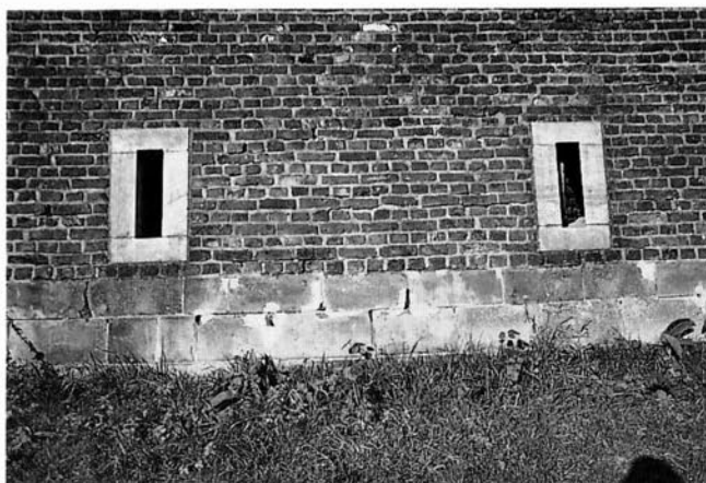
FIGUUR 12. Om te rigoreus gerestaureerde muren uit de periode 1977- 1982 (zie figuur 1) voor de Muurhagedis weer enigszins geschikt te maken werden holletjes, open voegen, winterholen en zonneplateautjes gecreëerd (foto: B. Kruytjens).
