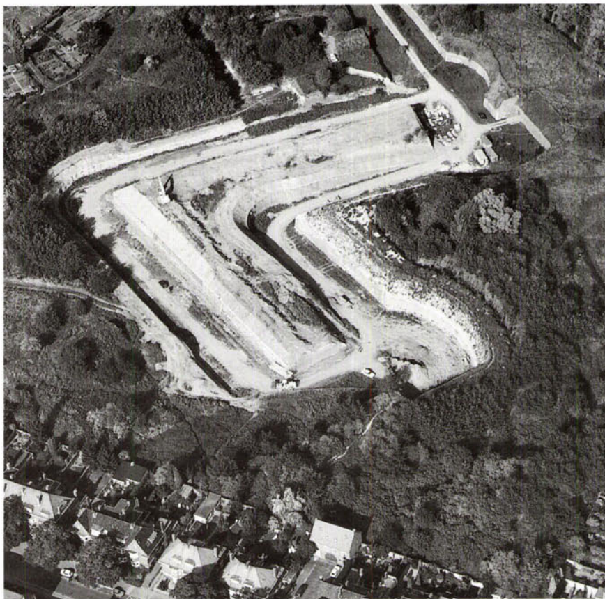
FIGUUR 3. Tijdens de consolidatie van bouwdeel I moest de bovenrand van de muren worden blootgelegd om deze op te kunnen metselen. De grondontgraving gebeurde echter zó grootschalig dat graafmachines dit deel van de Hoge Fronten tijdelijk omtoverden tot een maanlandschap (foto: Gemeente Maastricht).
