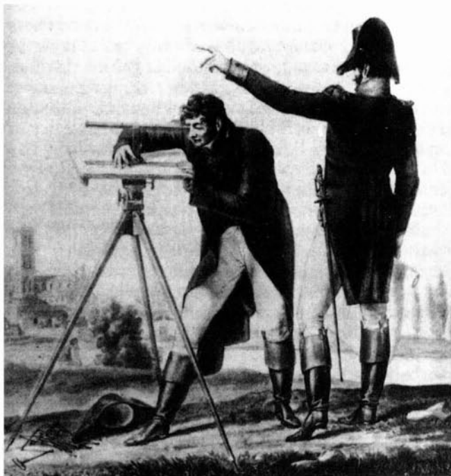
FIGUUR 8. Bij de opmetingen te veld werd door geografisch ingenieurs gebruik gemaakt van het planchet met vizierliniaal alsmede de meetketting (uit BERTHAUT, 1902).
