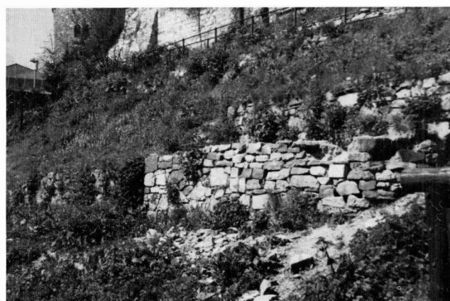
Figuur 13b. De nieuw gebouwde 'Trockenmauer' direct na nieuwbouw; nog niet geschikt voor kolonisatie (foto: U. Haese, 1986).
