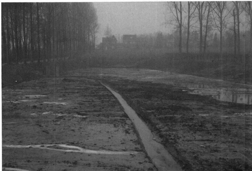
Figuur 4. Overzicht van de buffer Retersbeek direct na aanleg.
