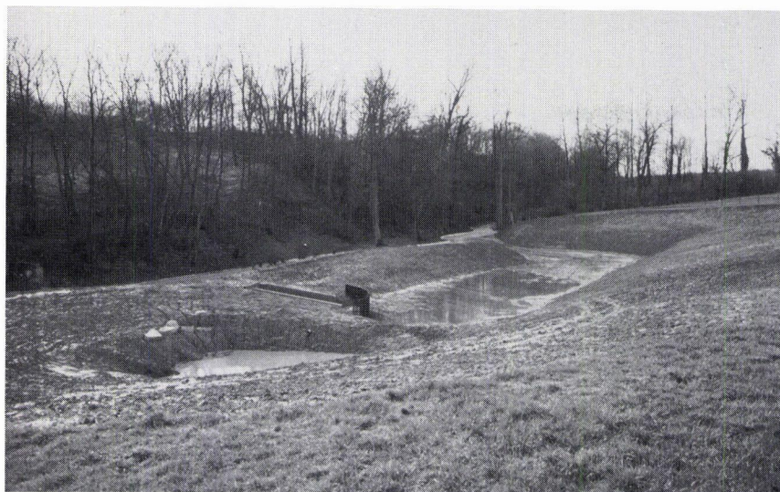
Figuur 10. Overzicht van de buffer Nagelbeek kort na aanleg.
