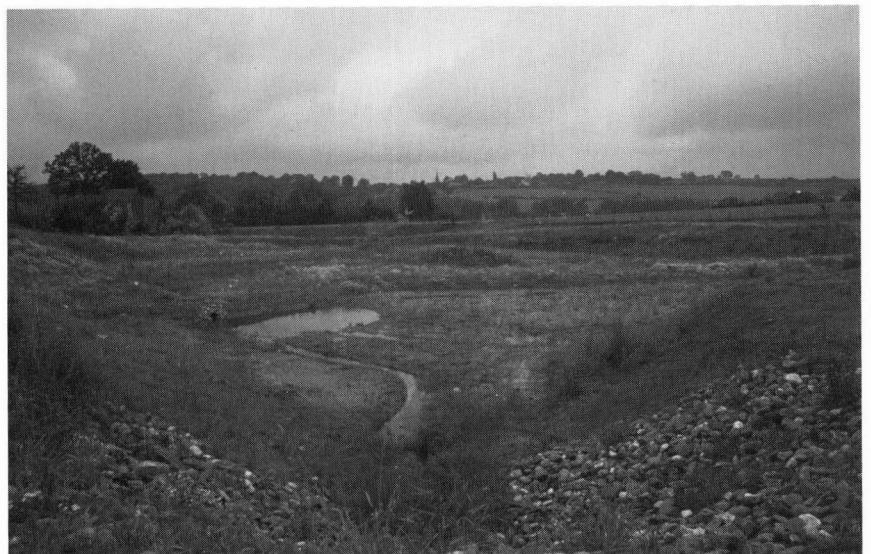
Figuur 3. Overzicht van de buffer oude Maastrichterweg kort na aanleg.
