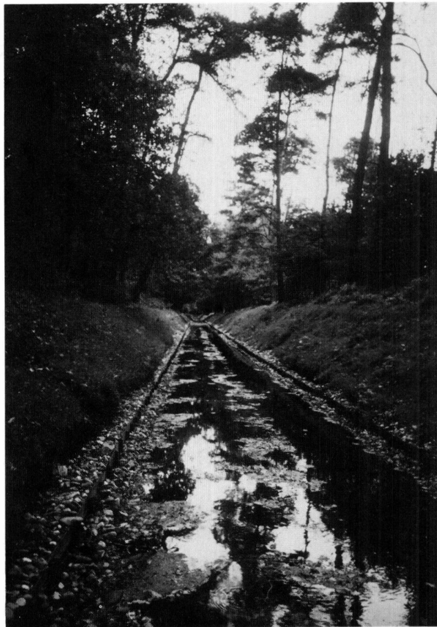
Figuur 4. De Oude Graaf: een nog niet geprofileerd deel en een deel direct na het aanbrengen van het nieuwe oeverprofiel. Links met een mozaïekvormige vegetatie en gevarieerde oevers op het nog niet geprofileerde deel en rechts direct na het aanbrengen van het nieuwe oeverprofiel waarover in de toekomst nog zand wordt gestort waardoor echter vrij eenvormige oevers zullen overblijven.
