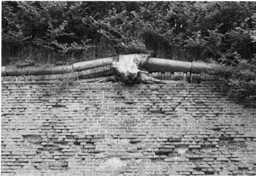
Figuur 14. Het zijn met name de houtige gewassen die d.m.v. hun uitgebreide, dikke en diep doordringende wortelstelsels de oude muren geheel ontwrichten, zoals hier in de Hoge of Bossche Fronten te Maastricht.
