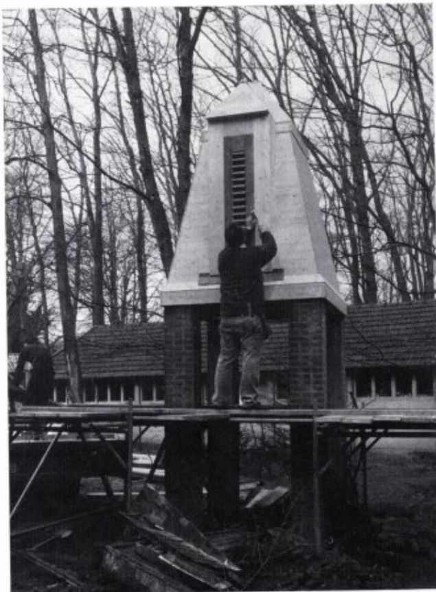
Figuur 3. Het aanbrengen van de "persiënne", 3 april 1987 (foto A.M. Voûte)
