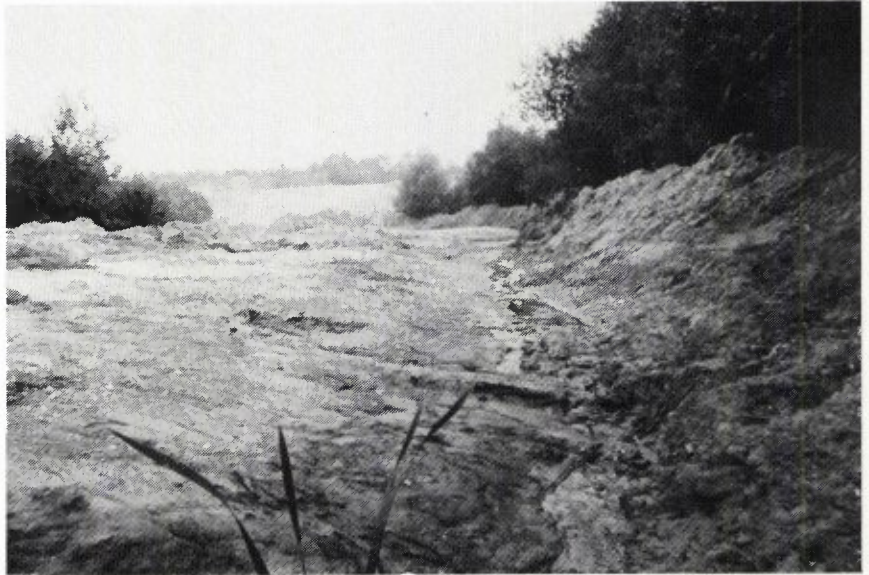
Figuur 3. Beeld van werkzaamheden (foto: H. Peters).
