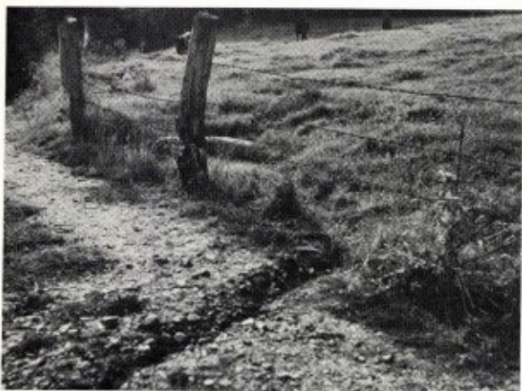
Poel van het type 2. Ronde ingezonken betonnen ring, met regenwater-aanvoer via een gegraven sleufje.
