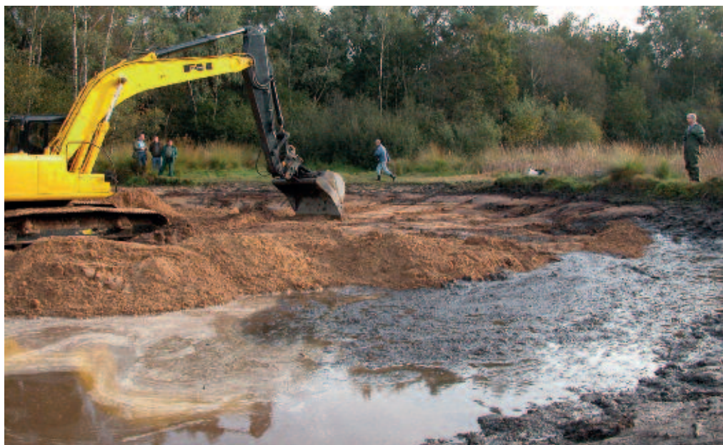
Foto 3. Werkzaamheden voor het verondiepen van het Rauwven als afsluiting van de zonnebaarsbestrijding (foto: Wilbert Bosman).
