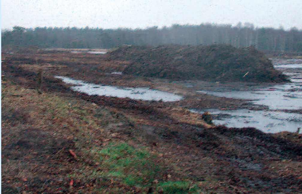
Herstelwerkzaamheden in januari 2006 (foto: Eva Eigenhuijsen).
