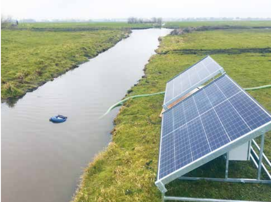
Zonnepomp om slootpeilniveau op te zetten (foto: Mark Kuiper).
