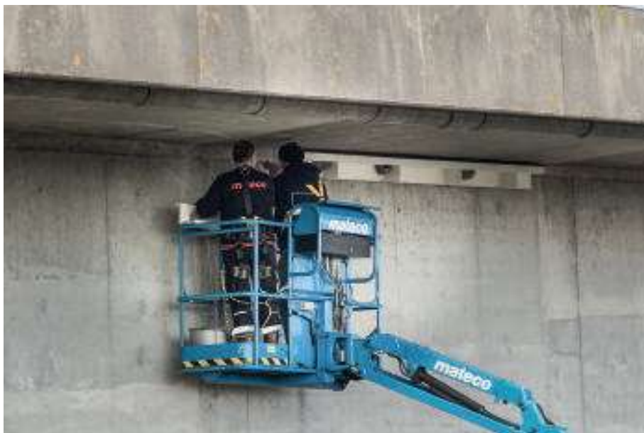
De panelen worden bevestigd.
