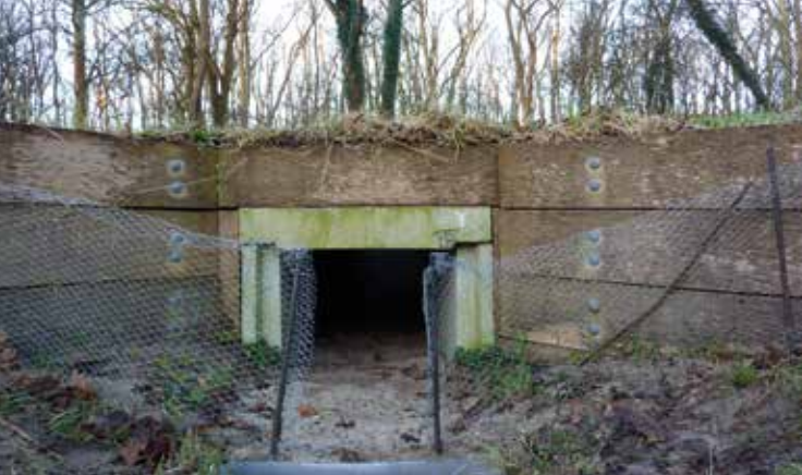
● Tunneluitgang met gaas naar opvangbak. Foto: Anneke Koper.
