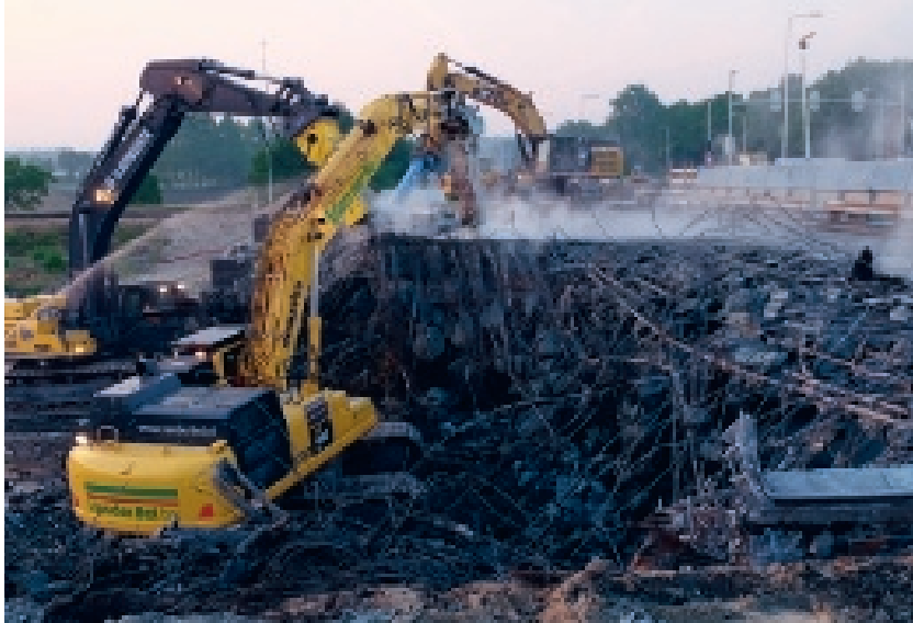
Foto 3. Het slopen van een viaduct dichtbij een dassenburcht. Foto: Rijkswaterstaat.
