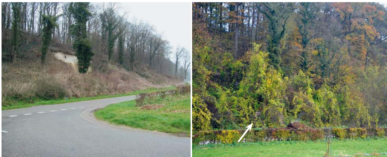
AFBEELDING 8. | Het geologisch monument Moerslag. Na het aanleggen van het monument, rond het begin van deze eeuw, was de kalksteenwand duidelijk zichtbaar (links). In november 2014 is wel nog het informatiebord bij de groeve te zien (witte pijl). De kalksteenwand gaat achter de begroeiing schuil.
