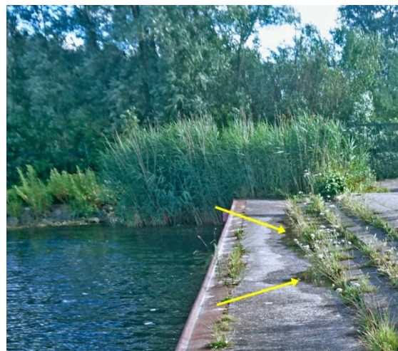
Foto 1. Regenwaterplasjes op verweerd beton. Foto © Koos Meesters
