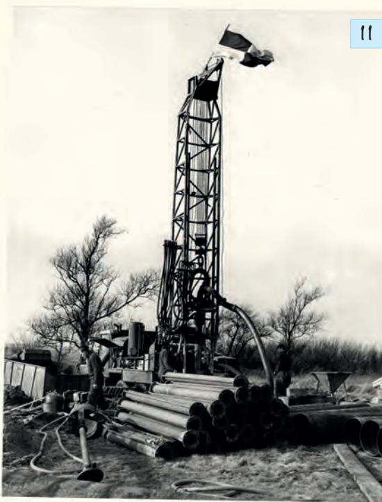
Moderne luchtliftboorinstallatie op Vliegveld Haamstede. V.l.n.r.: Janus Frijter, Willem Visser, Harm Sprang. Foto Rijkswaterstaat, 15-1-1969.
