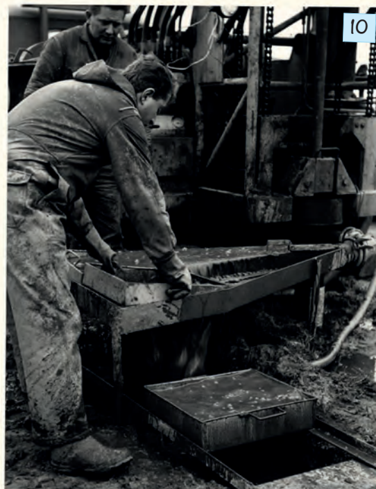
Monstername op een spoelboring op Vliegveld Haamstede. Ik zet hier een schoon monsterbakje in het frame, op achtergrond Arend Tholen. Foto Rijkswaterstaat, 15-1-1969.
