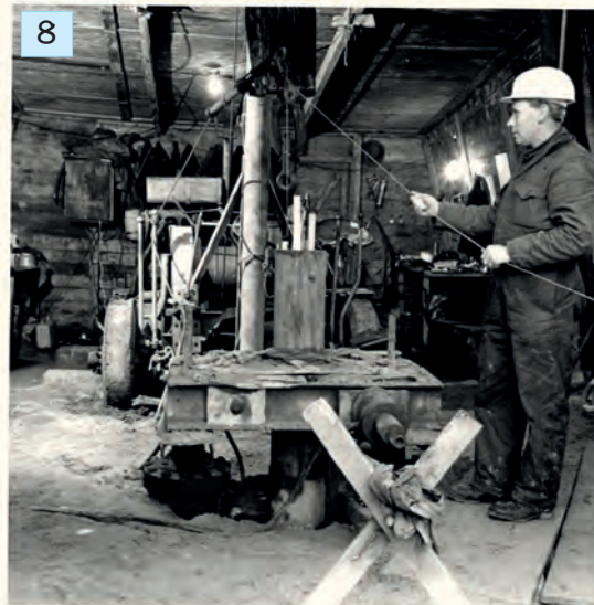
In het boorgat werden waarmemingsfilters geplaatst om het diepere grondwater te monitoren. Met de peildraad werd de positie van filtergrind en afdichtingen gecontroleerd. Hendrik Bennink. Foto Rijkswaterstaat, 21-4-1965.
