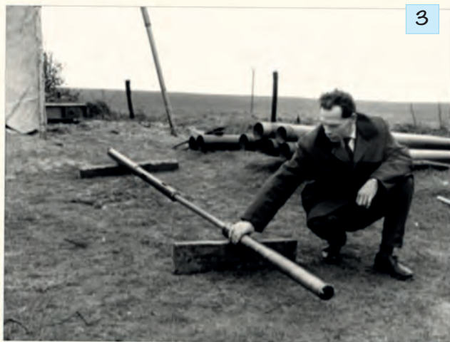
Collega Burger bij een steekapparaat van Grondboorbedrijf H. Haitjema & Zn. Een zware lange 'slagschaar' met een steekbus van 1 meter lengte. Goeree-Overflakkee. Foto Rijkswaterstaat 24-4-1965.
