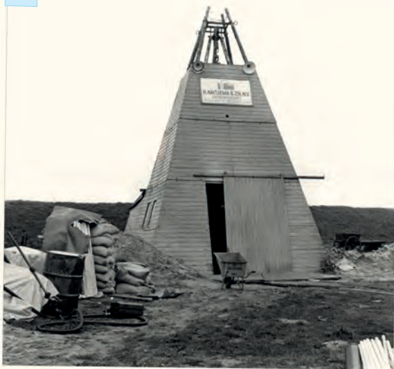
Diepe boring door Grondboorbedrijf H. Haitjema & Zn. achter de zeedijk bij Den Bommel op Goeree-Overflakkee. Deze boorkeet is later, bij Dirksland, tijdens een zware storm weggewaaid en 300 meter verderop op een akker teruggevonden. Hij is nooit meer gebruikt. Foto Rijkswaterstaat, 21-4-1965.
