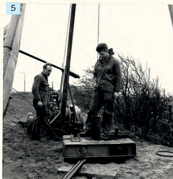
Opstelling van een pulsboring op Goeree-Overflakkee. Hiermee konden ook steekboringen gemaakt worden. Op de foto Joop van Gijsel (aan de lier) en Klaas Vogelzang van het boorbedrijf. Het klemblok op de voorgrond werd hydraulisch op en neer bewogen om de buizen op en neer te bewegen.
