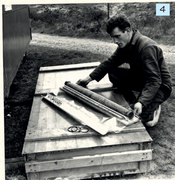
Dezelfde boring. Boormeester Klaas Vogelzang met een steekmonster van 1 meter lengte dat wordt ingepakt. Foto Rijkswaterstaat, 24-4-1965.
