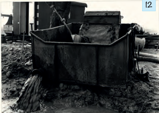
Dezelfde boring op Vliegveld Haamstede. Monsternemen met de schepemmer. Janus Frijter. Door de afvoer van de container af te sluiten kon de gehele boorgatinhoud worden opgevangen. Foto Rijkswaterstaat, 15-1-1969.
