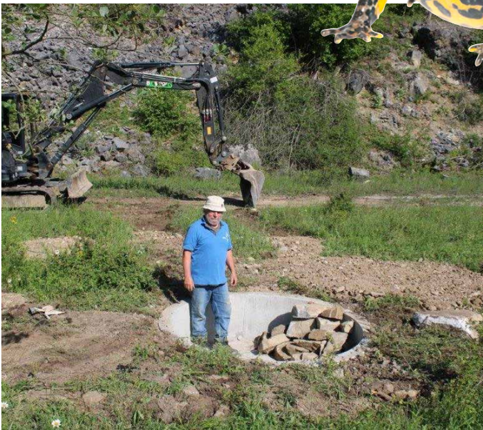
Wil Niessen aan het werk bij de aanleg van een betonpoel. (Foto: Naomi Lambrikk)
