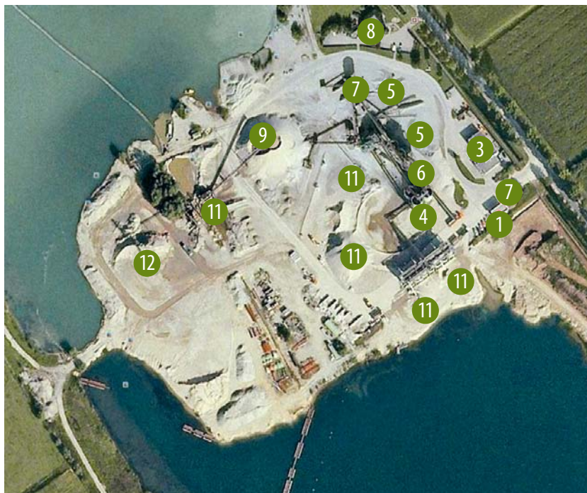
AFBEELDING 4. | Het bedrijfsterrein van de winning Azewijnse Broek vanuit de lucht. 1. Kantoor met controlekamer en kantine; 2. Weegbrug met ingang winning; 3. Werkplaats; 4. Fractiesilo's; 5 = Grindsoortenvoorraad; 6. Grindsilo's; 7. Grind, voorraadsilo's; 8. Hoofdkantoor; 9. Voorraadhal moedermateriaal; 10. Scheprad; 11. Zandsoortenvoorraad; 12. Ophoogzand.
