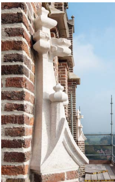
AFBEELDING 18. | Pinakels van Portland kalksteen aan de bakstenen toren van Asperen.
