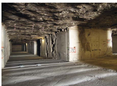
AFBEELDING 11. | Ondergrondse winning (Jordan's mijn). Het plafond wordt gevormd door kalksteen met vuursteenknollen.
