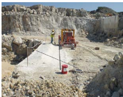
AFBEELDING 9. | Zagen van een sleuf aan de bovenzijde van een steenbank.
