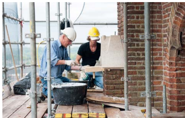
AFBEELDING 17. | Stellen, voegen en vastzetten met doken van het natuursteen onderdeel.
