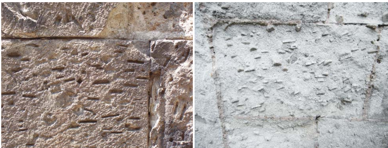
AFBEELDING 5. | De geologische lineatie, gevormd door de sanidienfenokristen, is ook in veel bouwstenen van Drachenfels trachiet nog duidelijk herkenbaar, zoals links aan de Proosdij in Deventer en rechts aan de Gross St. Martin in Keulen.
