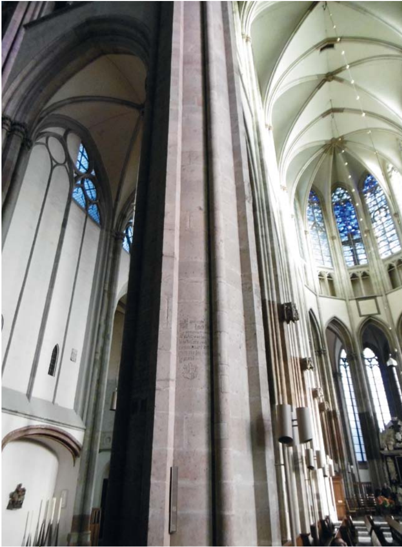
AFBEELDING 7. | Vieringkolom uit Drachenfels trachiet in de Dom in Utrecht.
