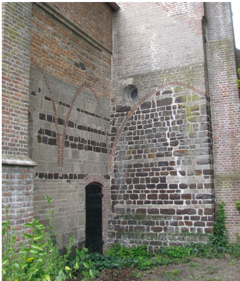
AFBEELDING 10. | De Oude Kerk in Ermelo is deels gebouwd met ijzeroer, tufsteen en baksteen.
