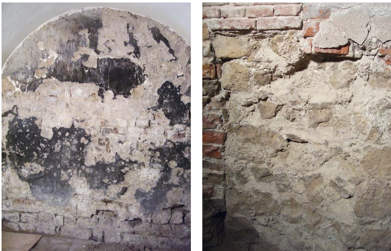
AFBEELDING 4. | Romeins muurwerk uit Römer tuf onder Domplein 4 in Utrecht (voor de herinrichting). De foto links toont een stuk muur waarvan het onderste, regelmatige deel oorspronkelijk Romeins metselwerk is en het hogere, onregelmatig en deels van afwerking voorziene deel later opnieuw is opgetrokken met secundair materiaal. De rechter foto toont een doorsnede van het muurwerk.
