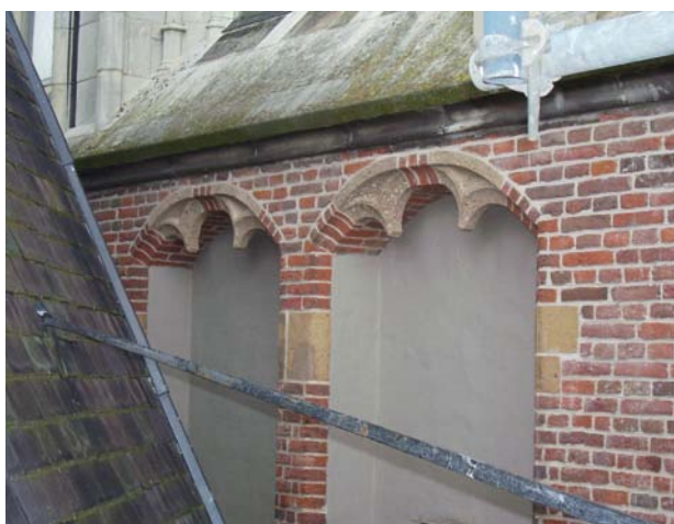
AFBEELDING 11. | Laacher tuf uit de 18e eeuw aan de viering van de Sint Janskathedraal te 's-Hertogenbosch. De linker foto geeft een overzicht, waarin de oranje blokken Laacher tuf zijn en de beige blokken in de ronding van de blindnissen Römer tuf; rechts een detail van een blok Laacher tuf uit de jaren 1730.
