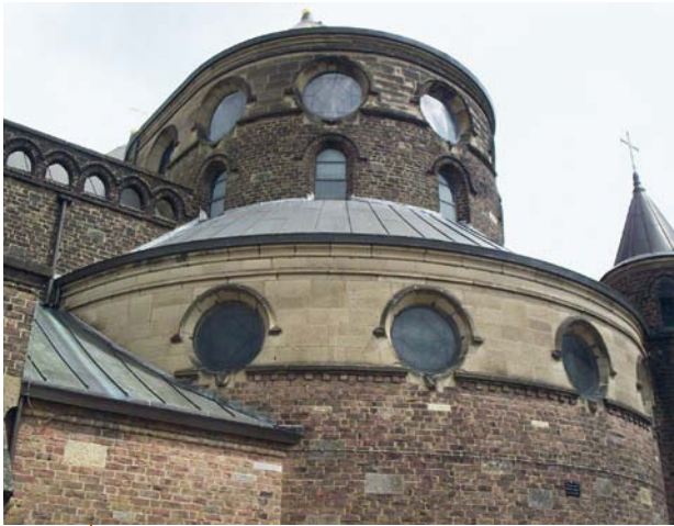
AFBEELDING 17. | Ettringer tuf werd in de jaren '30 en '50 regelmatig gebruikt in combinatie met baksteenmetselwerk, zoals op de foto links aan de absis van de Sint Jacobus de Meerdere kerk in Enschede van de architecten H.W. Valk en J.H. Sluijmer uit 1933 en rechts aan het voormalige stadhuis van Medemblik van de architect Kropholler uit 1939.
