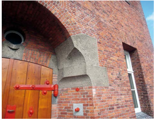
AFBEELDING 17. | Ettringer tuf werd in de jaren '30 en '50 regelmatig gebruikt in combinatie met baksteenmetselwerk, zoals op de foto links aan de absis van de Sint Jacobus de Meerdere kerk in Enschede van de architecten H.W. Valk en J.H. Sluijmer uit 1933 en rechts aan het voormalige stadhuis van Medemblik van de architect Kropholler uit 1939.
