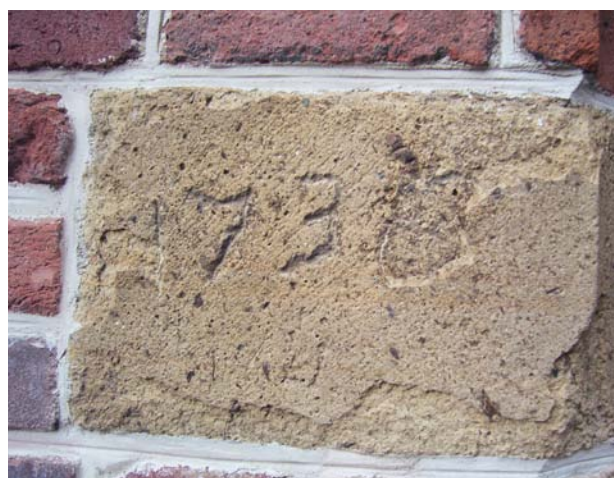
AFBEELDING 11. | Laacher tuf uit de 18e eeuw aan de viering van de Sint Janskathedraal te 's-Hertogenbosch. De linker foto geeft een overzicht, waarin de oranje blokken Laacher tuf zijn en de beige blokken in de ronding van de blindnissen Römer tuf; rechts een detail van een blok Laacher tuf uit de jaren 1730.
