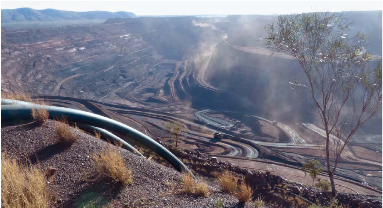
AFBEELDING 7. | De Mt. Whaleback ijzermijn bij Newman, in gebande ijzerertsen van de Hamersley Range van W. Australië, afgezet rond de grens tussen Archaicum en Proterozoicum, 2,5 miljard jaar geleden. Deze 'main pit' meet 5 bij 3 km, is 400 m diep en is in gebruik sinds 1969. Foto: Frank Beunk.
