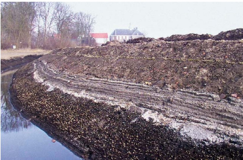
AFBEELDING 13. | In de sloot bij de Middelbuurt is de veenlaag met de gelaagde schelprijke zavellaag mooi te zien. Op de zavellaag ligt een kleilaag waarin stukken baksteen zijn terechtgekomen. Op de graslaag ligt het materiaal dat tijdens het graven van de sloot hierop is gegooid. (Foto: Museum Schokland)
