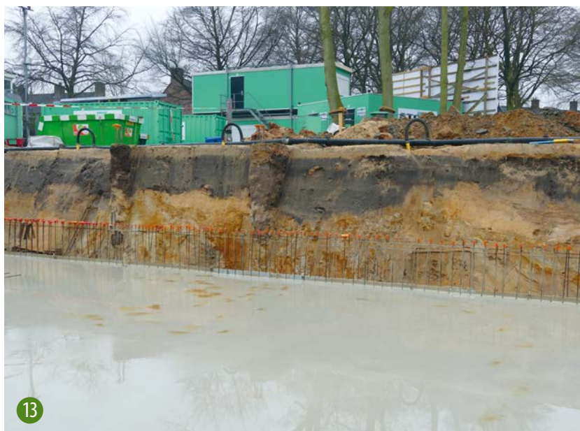
AFBEELDING 12. | Waarnemingspunt 6, bruine stenenarme keileemlaag met een dikte van ongeveer 30 cm (formatie van Drenthe, Laagpakket van Gieten). Onderaan enkele insluitsels van kwartsrijk zand uit de onderliggende formaties.
