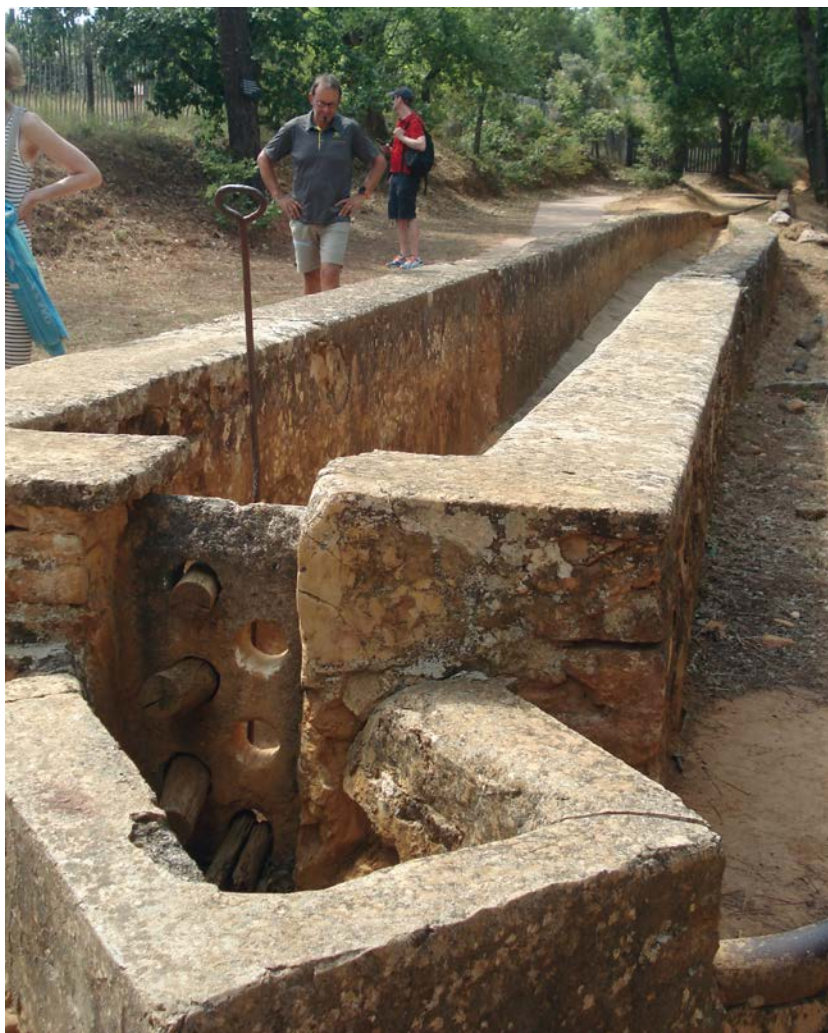
AFBEELDING 7. | Bezinkgoot op het terrein van de voormalige okerfabriek Mathieu bij Roussillon. Hier werd de okeraarde gemengd met water om zand en fijne fractie (okerslib, of 'pulpe') te scheiden.
