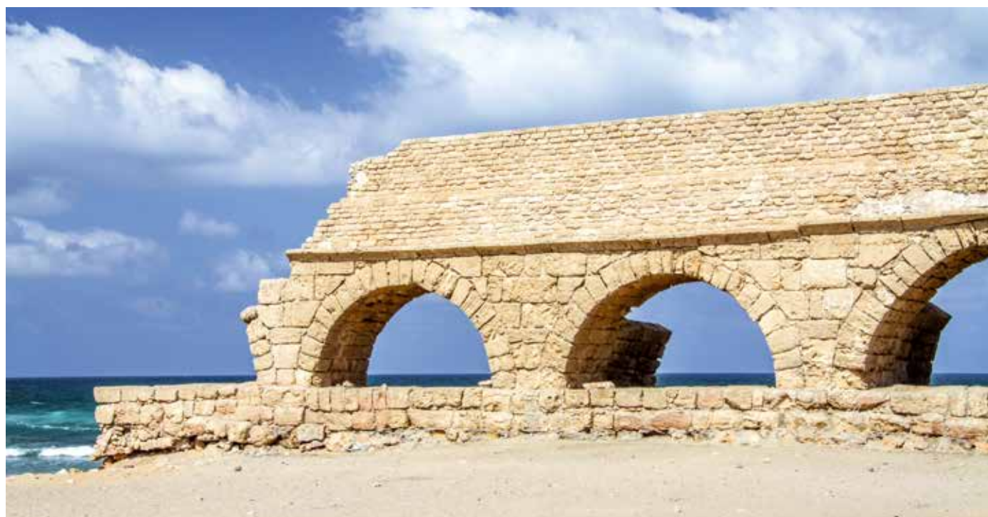
Afb. 1. Het Romeinse aquaduct bij Caesarea heeft, ondanks blootstelling aan zeewater, de tand des tijds grotendeels overleefd. Foto: Wikimedia Commons/Chmee2 via CC-BY-3.0.
