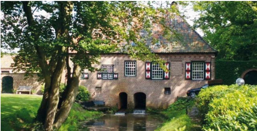
AFBEELDING 9. | De watermolen in Deurne (Foto: auteur).
