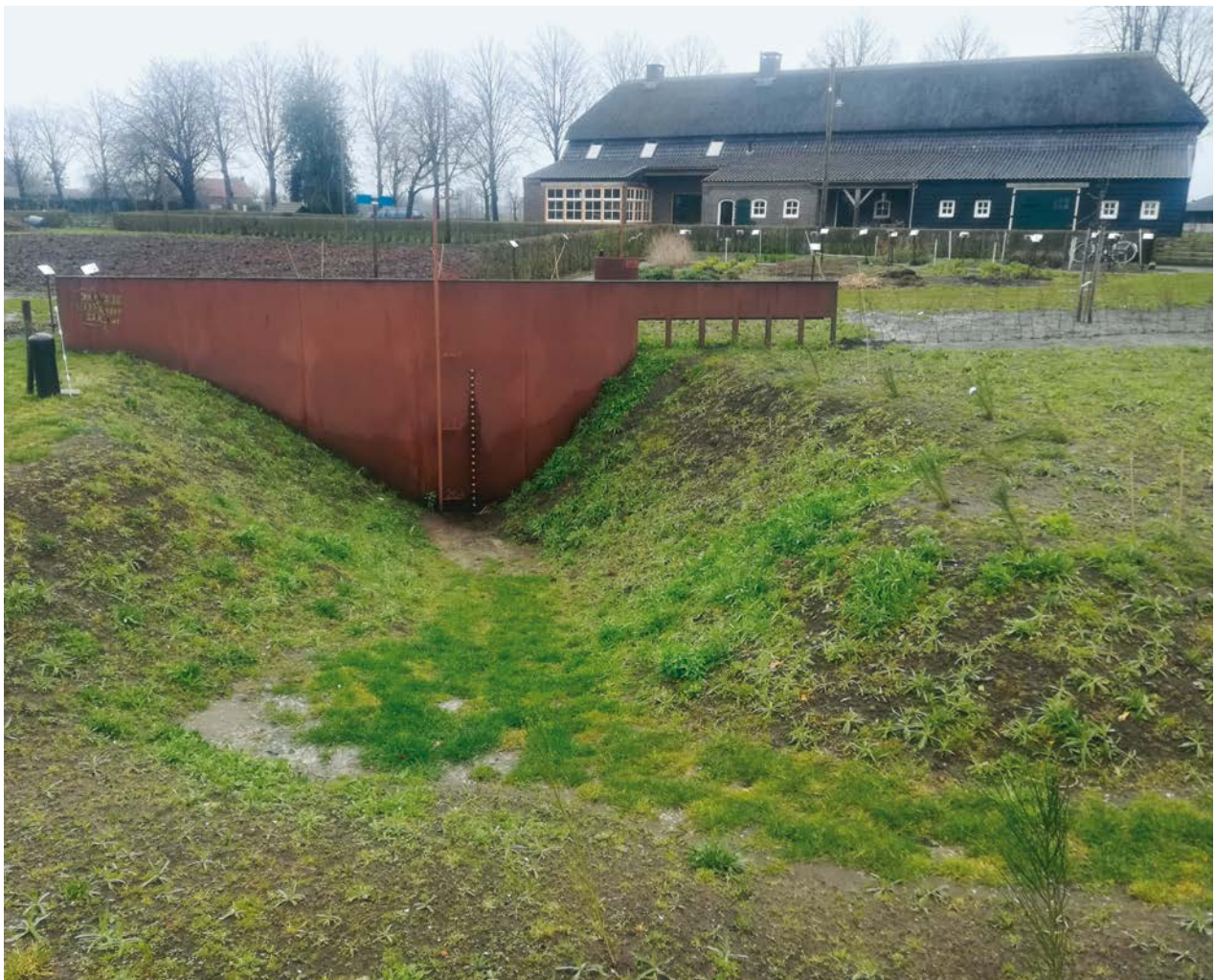
AFBEELDING 2. | Op het terrein van "Bijzonder Brabants", bij Deurne, is de grondwatersprong bij de Peelrandbreuk zichtbaar gemaakt door middel van een metalen scherm.
