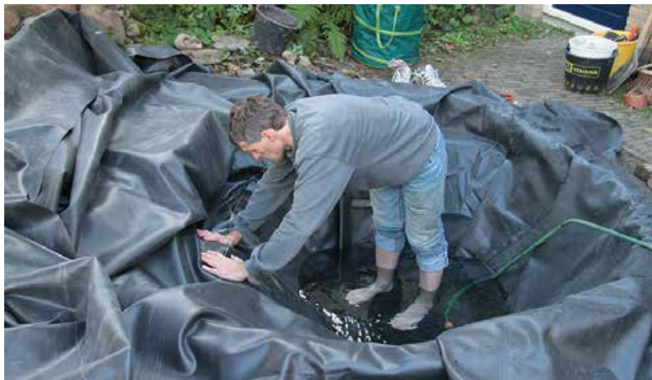
folie aanbrengen
