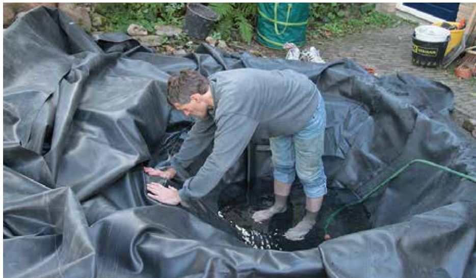
folie aanbrengen
