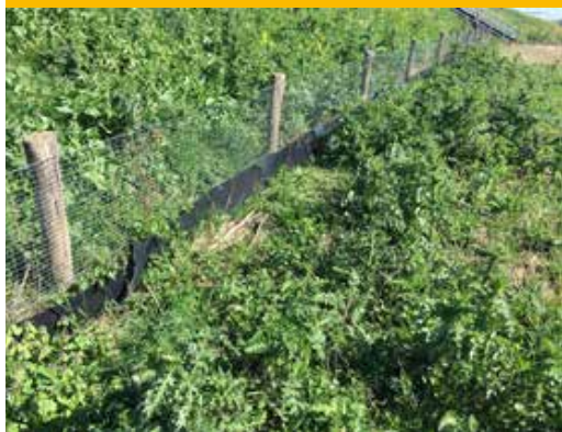
Figuren 4 t/m 6. HDPE-geleidingsschermen in het onderzoeksgebied anno 2021: defecten en overgroeiing door vegetatie zorgen voor verlies aan functionaliteit, waardoor ze voor ringslangen eenvoudig passeerbaar zijn. (Foto: R. Struijk) Betonnen schermen met overstekende rand en voetvlak zijn duurzaam en behouden hun functionaliteit. (Foto's: R. Struijk & Maibach GmbH)
