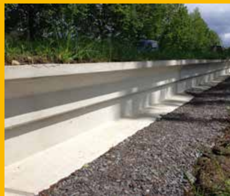
Figuren 4 t/m 6. HDPE-geleidingsschermen in het onderzoeksgebied anno 2021: defecten en overgroeiing door vegetatie zorgen voor verlies aan functionaliteit, waardoor ze voor ringslangen eenvoudig passeerbaar zijn. (Foto: R. Struijk) Betonnen schermen met overstekende rand en voetvlak zijn duurzaam en behouden hun functionaliteit. (Foto's: R. Struijk & Maibach GmbH)
