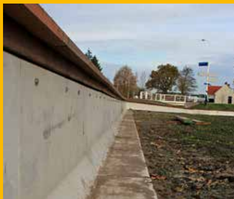
Figuren 4 t/m 6. HDPE-geleidingsschermen in het onderzoeksgebied anno 2021: defecten en overgroeiing door vegetatie zorgen voor verlies aan functionaliteit, waardoor ze voor ringslangen eenvoudig passeerbaar zijn. (Foto: R. Struijk) Betonnen schermen met overstekende rand en voetvlak zijn duurzaam en behouden hun functionaliteit. (Foto's: R. Struijk & Maibach GmbH)
