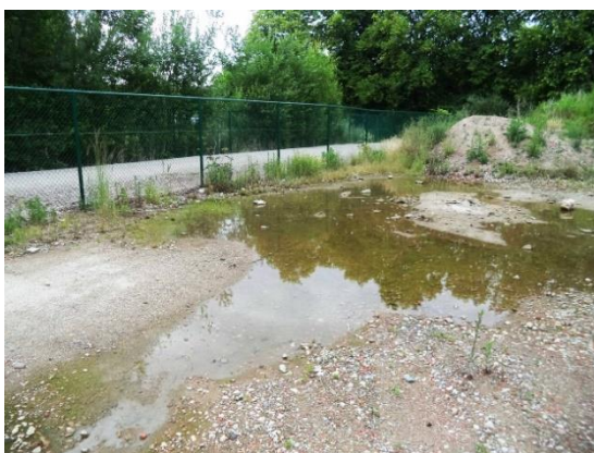
Foto 5, 7 Juni 2022. werf Sint-Gabriëlcollege, Boechout. Plas met baksteen en beton (kalkrijk?). Foto © Roland Luts.
