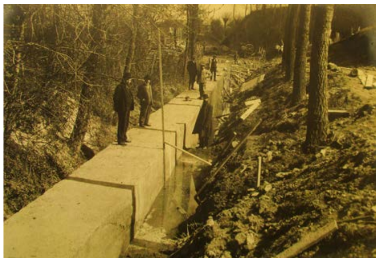
FIGUUR 3 Aanleg waterleiding naar Heerlen bij de Zevensprong (archief: Hary van Aken).
