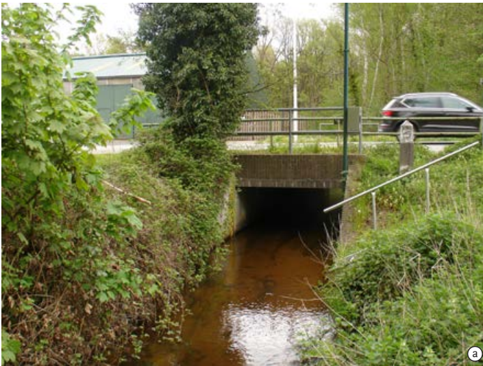
▲ FIGUUR 13a Migratieknelpunt bij Rothenbach. De Roode Beek loopt hier op de rijksgrens met een duiker onder de N570 door (foto: Steven Jansen).
