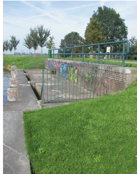
Fig. 2: Inundatiesluis in de Zuiddijk aan de Beemster – buitenkant aan het Noordhollands Kanaal.
