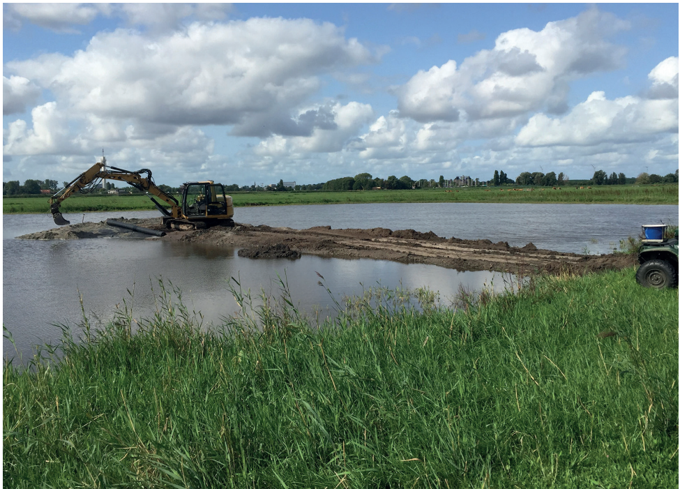
AANLEG EILANDJE in Spaarnwouderplas in 2018. Foto: Gertjan van Tunen
