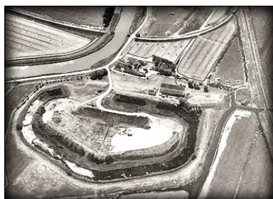
Fig. 1. Een historische luchtfoto van Fort Kwadijk. Slechts het voorterrein met de fortwachterswoning en de genieloods zijn bewaard gebleven. Fotograaf: bron onbekend.
