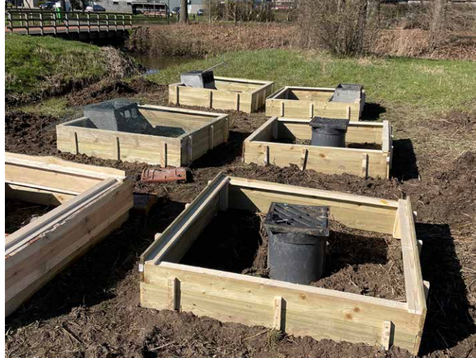
Proefopstelling met 4 rechthoekige trottoirkolken en 2 ronde straatkolken (Foto: Raymond Creemers)
