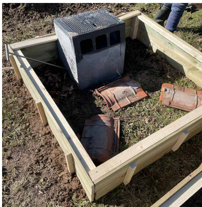
Opvangbak rondom trottoirkolk met drie schuilplaatsen. (Foto: Raymond Creemers)
