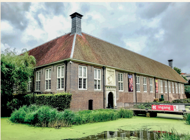
Afb. 1. Het Pesthuis, het huidige entreegebouw van Naturalis. Foto: B. Schuchmann (augustus 2018).
