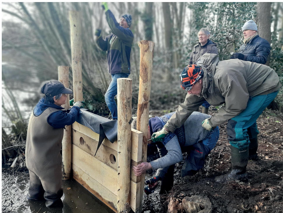
Het plaatsen van de HOUTEN WAND bij Ipenrode. Foto: Marcel Slaterus
