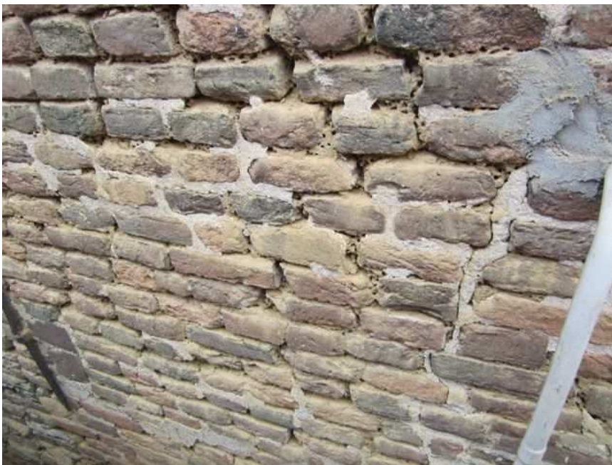
Figuur 1. De muur aan de Kruisstraat in Hattem, met verdwenen voegwerk en nestgangen van Colletes daviesanus . Foto: Iwan van Berkel.
