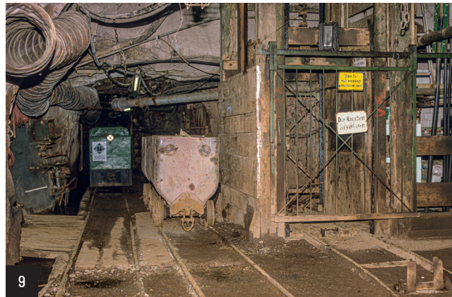
► Afb. 9 en 10. Inrijke in het Krunkelbachtal Uranium deposit in Menzenschwand. Bron (met toestemming): Franz Falkenstein uit Das Uran vom Menzenschwand , Christian Weise Verlag.
